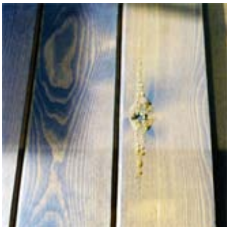
Fig. 9: la foto mostra una trasudazione di resina. Quando questa resina è cristallizzata deve essere asportata con una lametta. A operazione terminata intervenire carteggiando il punto incrinato e pennellare con vernice per correggere eventuali danni causati dal coltello.
